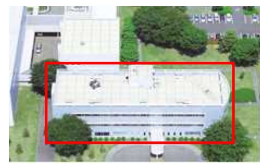
新菱冷熱工業(株) 中央研究所 (写真は現在) ※赤枠内の建物が建替え・検証対象の研究施設
